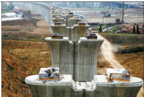
建设中的宁安城际铁路马鞍山段将给小城带来新活力。
