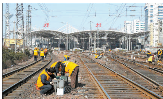
昨日,施工人员在郑州火车站轨道上作业。 新华社发
