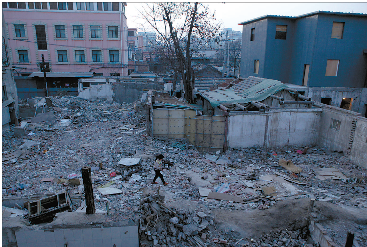
昨日,一名小女孩从废墟上走过。位于东城区北总布胡同24号院的“梁林故居”已被拆除。
