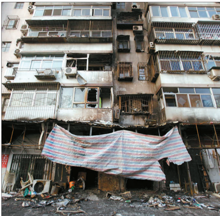
昨日，东木樨园6号楼下，火灾过后场景。
