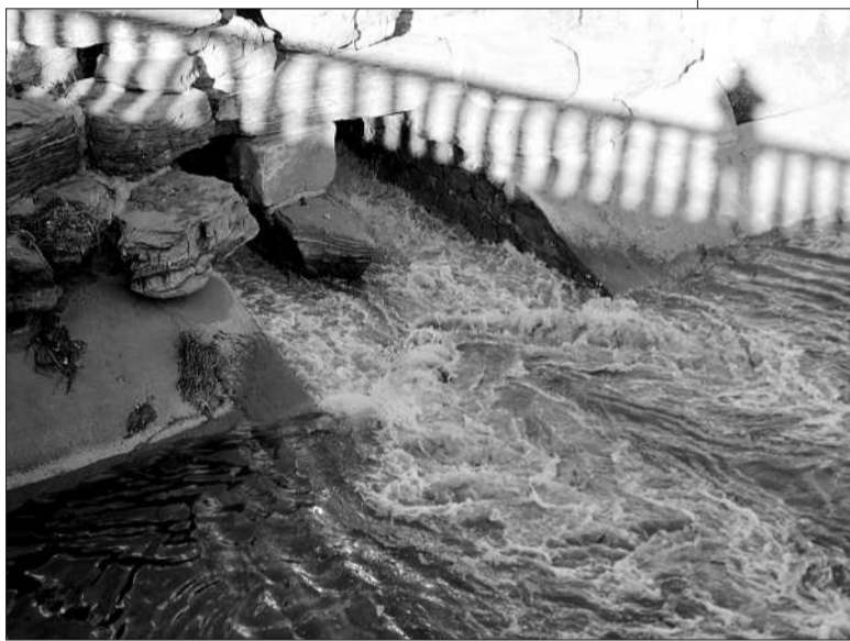
1月4日，清河附近一处河道的排水口，大量污水流进河道。本报记者 杨杰 摄
