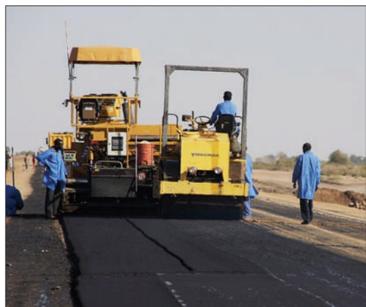
苏丹乌阿公路沥青路面施工。
