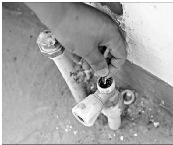
水管也是复工前检查的重点项目。
