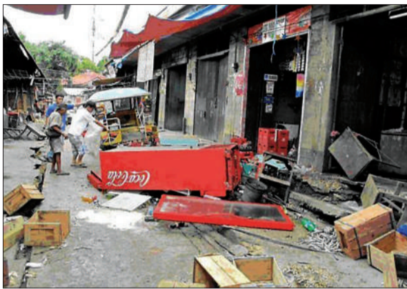
6日,菲律宾内格罗斯岛,地震导致多处建筑物坍塌。
