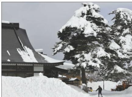
2月5日,日本岩手县,一栋古建筑的坡状屋顶积雪自行滑下。这种结构的屋顶有防积雪的效果。
