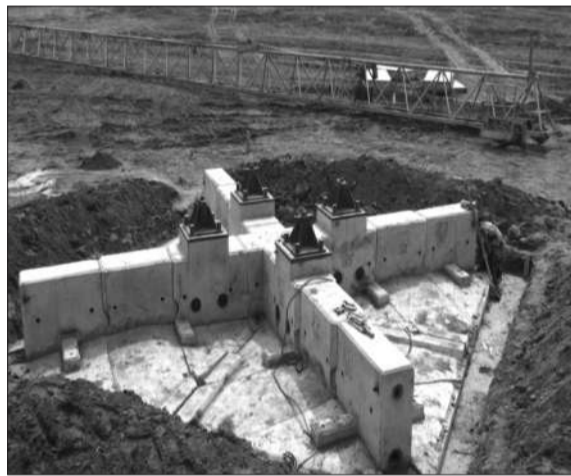
图为赵氏塔基,与传统塔基不同,赵氏塔基可以拆解、移动。
