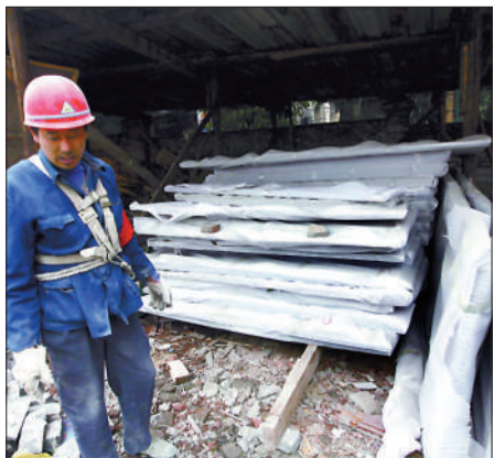
昨日,蒋介石行营施工现场,拆下来的建筑构件都用泡沫包裹后储存。 据《重庆晨报》
