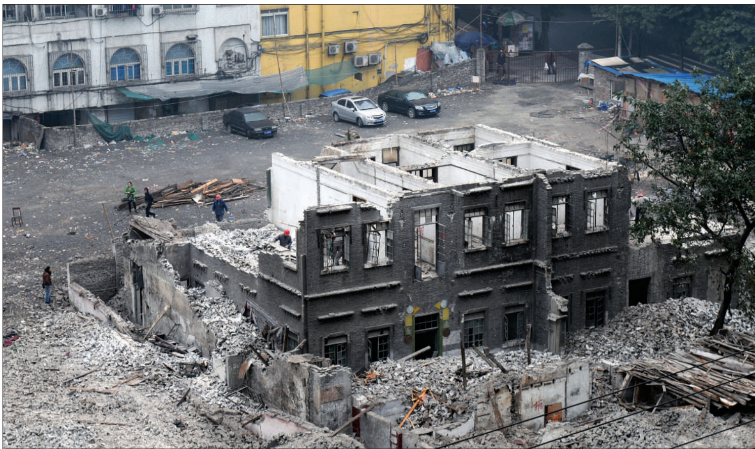
昨日,蒋介石“重庆行营”两楼一底的旧址屋顶已经完全被拆掉,仅剩砖木残体。
