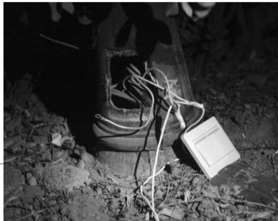
藤萝架东南角的路灯基座,井内拉出的电线与开关连接,按动开关,污水会抽到雨水井。
