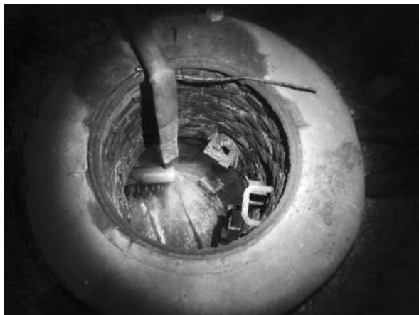
通过消防水带,提升井的污水会流入雨水井。
