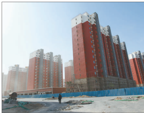
唐家岭3000套回迁房已完成外立面装修。本报记者 饶沛 摄
