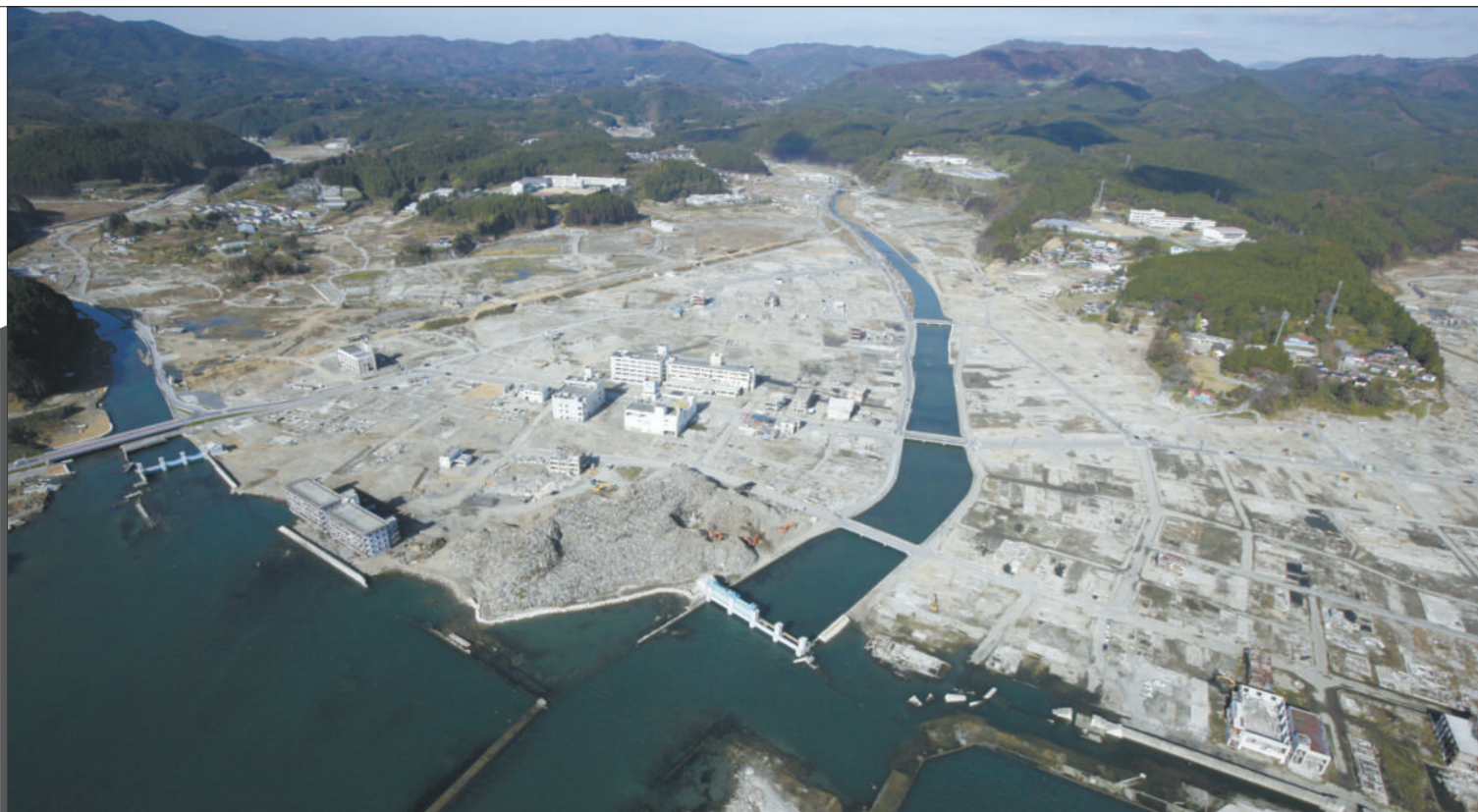
2011年11月18日,日本宫城县石卷市,经过8个月的重建工作,建起的社区航拍图。
