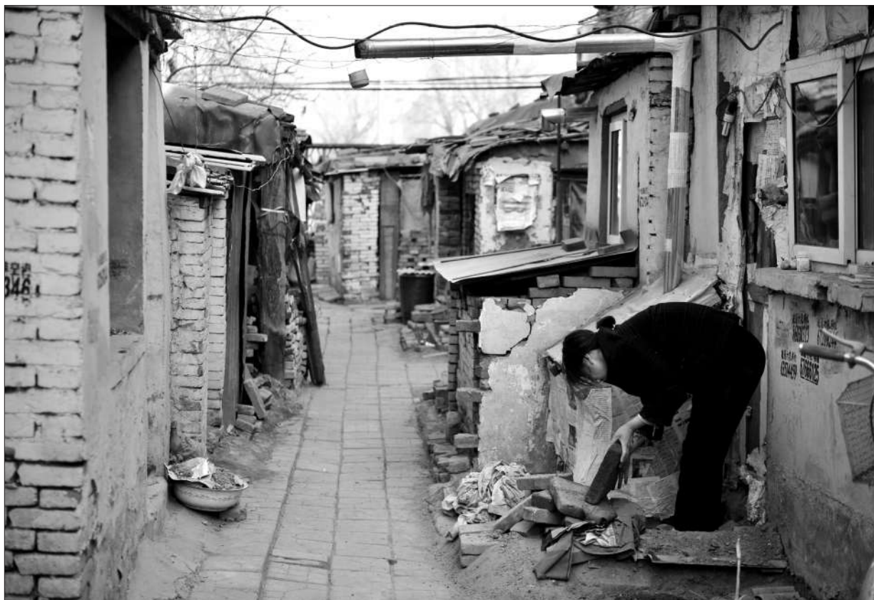
3月13日,天坛东里北区,一位居民正在用砖修门槛。北区8栋上世纪60年代的简易楼这次改造将全部拆除。
