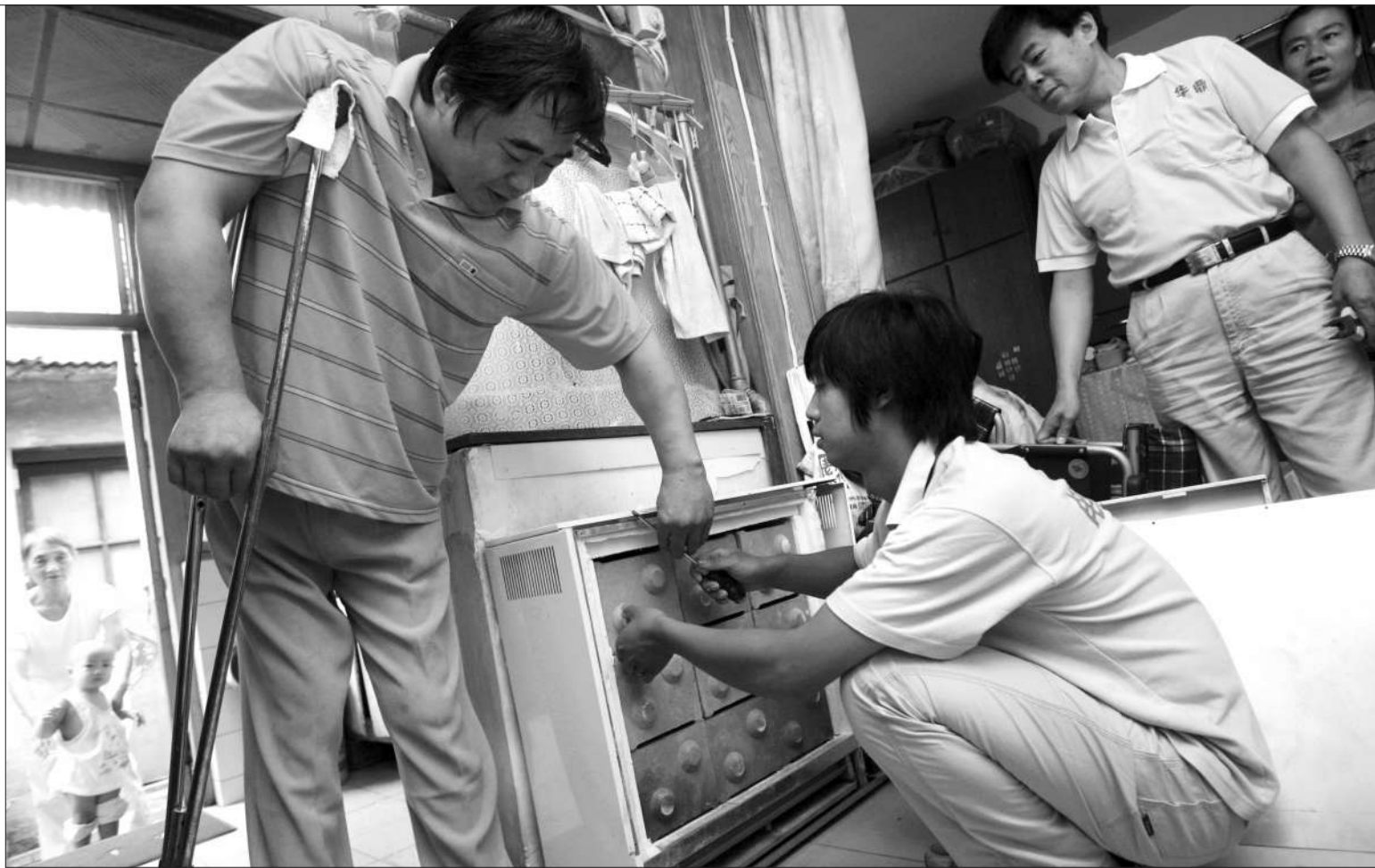
2009年8月18日,东城区“煤改电”工程工作人员正在为低保户绍先生家免费检修电暖器。
