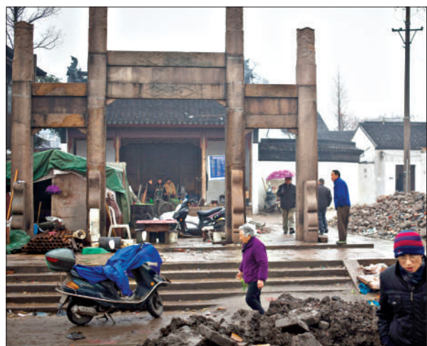
阊门一带部分老屋被拆除, 街口的老牌坊却保留了下来。
