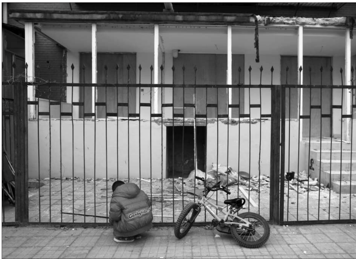
昨日,朝阳区新源里西11号楼,一楼的自建玻璃房被拆除,门窗已被施工人员用木板封上,一名小男孩在院子门口玩耍。本报记者 薛珺 摄
