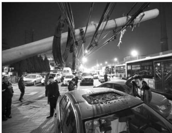
昨晚,成寿寺路北口,3根电线杆折断,其中1根砸中路边一辆汽车车顶。 本报记者 王嘉宁 摄
