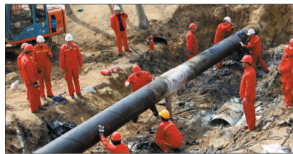
挖掘机将地面挖开后，工人正在抢修河道中的输油管道。
