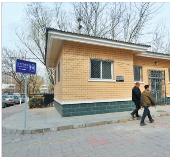
朝阳区北苑家园春华路东口西侧的二级公厕去年建成后,仍未投入使用。崔楠摄
