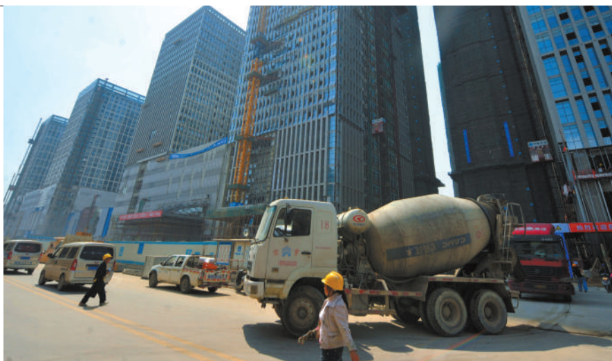
28日,位于泉州市区江滨路附近的土方车、水泥运输车。
