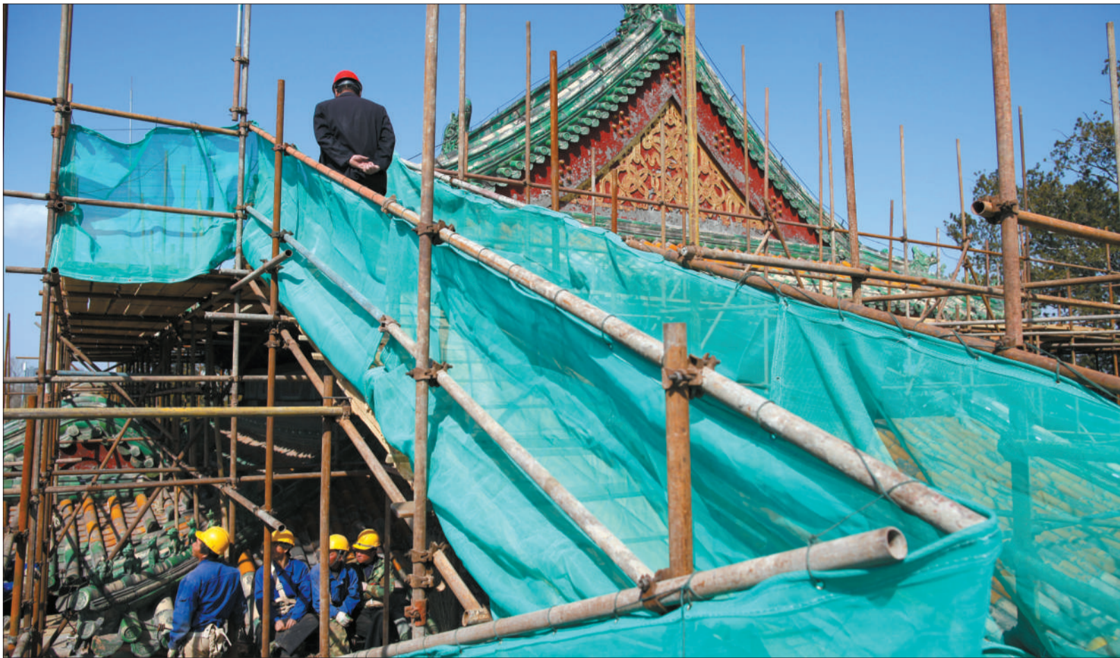
承光殿顶部,工人正在施工。昨日,北海团城启动了新中国成立以来最大规模的修缮。此次修缮中,团城上的主要古建承光殿将挑顶大修,“文革”期间被更改的团城彩画将恢复成清中晚期的样式。
