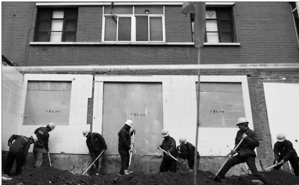
昨日,朝阳区新源里西11号楼,施工人员挖掘地面准备打桩。
