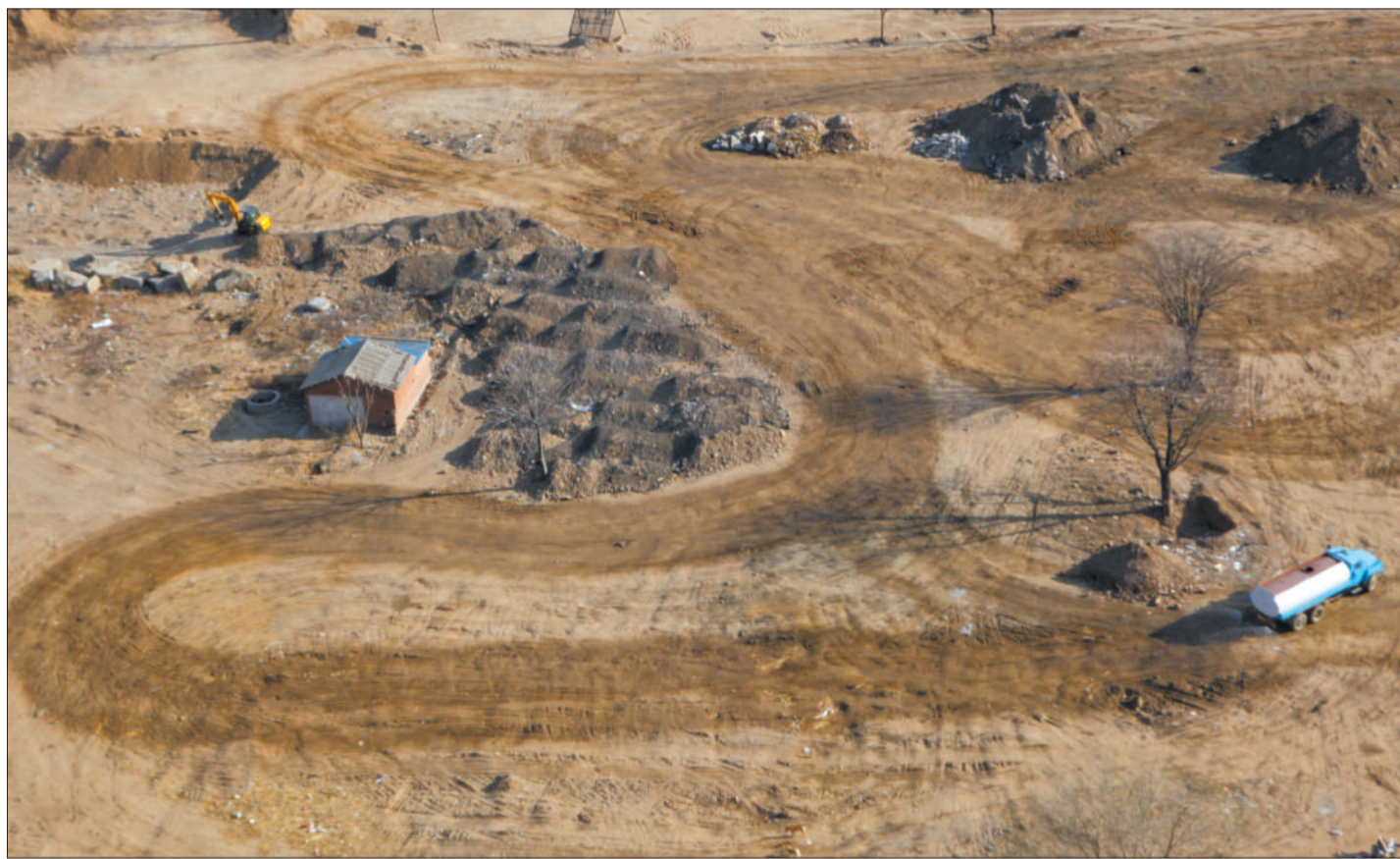
昨日,经曝光后,丰台区岳各庄北桥东侧一工地,在施工时用洒水车在工地上洒水。
