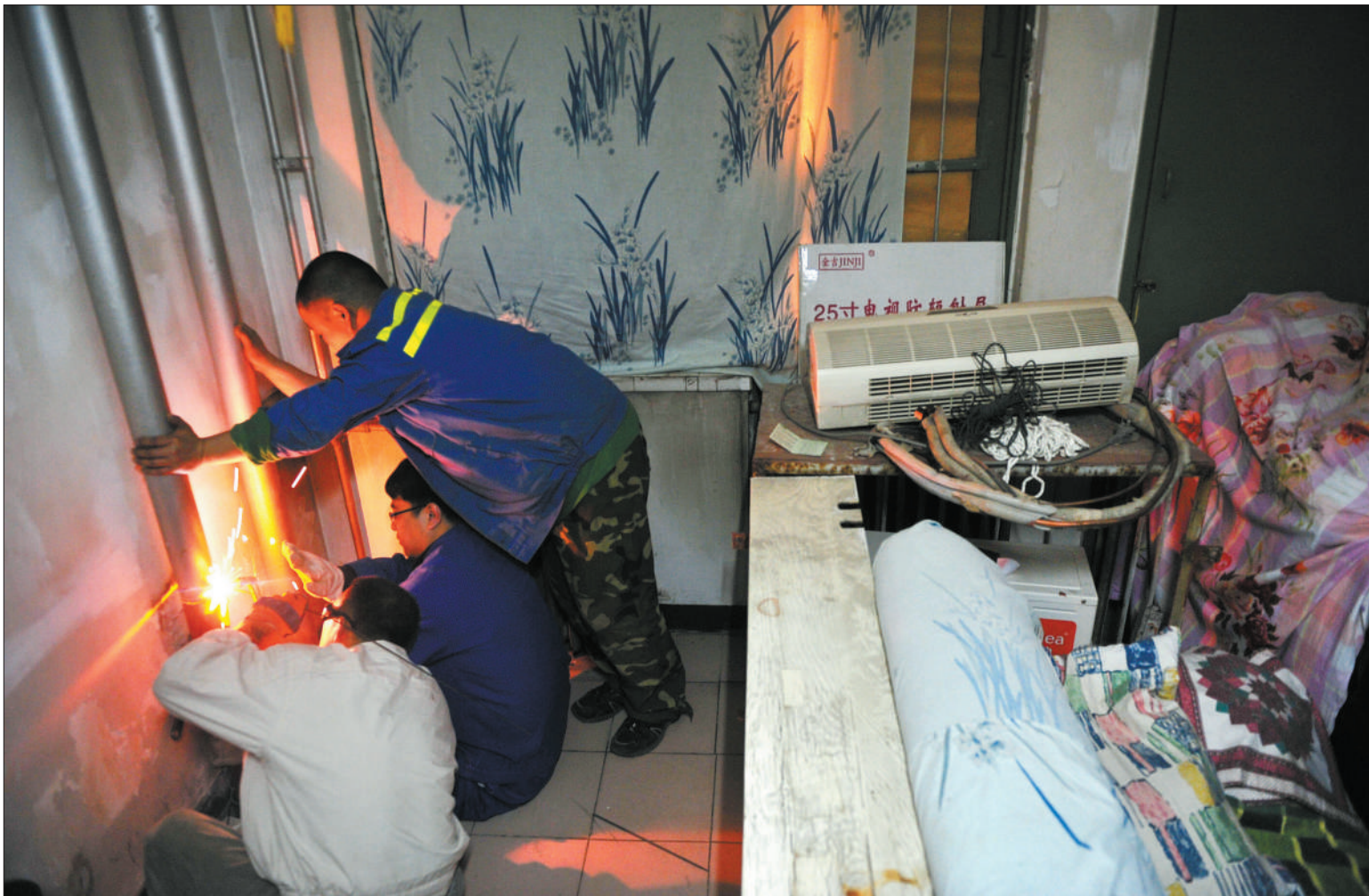
昨日下午，朝阳区新源里西11号楼二单元1楼居民家中正在焊接新的暖气管道，当日，这栋楼正在进行抗震节能综合改造试点工程。
