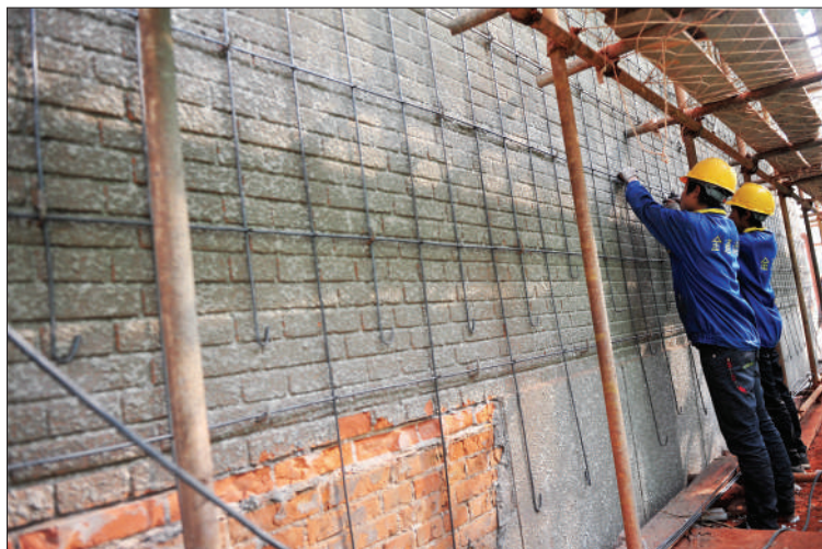
昨日，两名工人正在墙体侧面铺设安装保温层的钢筋。
