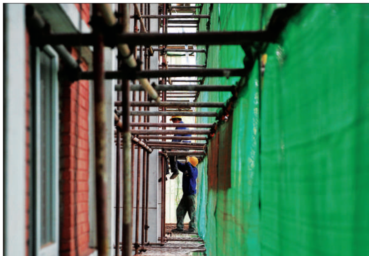
昨日，几名工人正在拆除墙体外面的防盗护栏和窗户。
