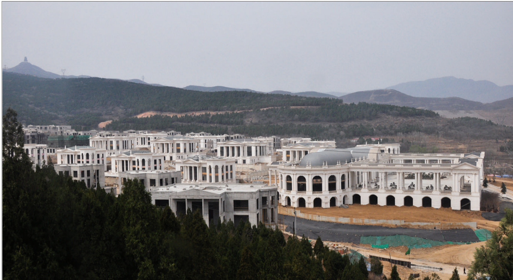
记者沿门头沟区永定镇万佛堂上山走了15分钟,在一个不起眼的山坡下才发现中骏绿洲庄园的身影。
