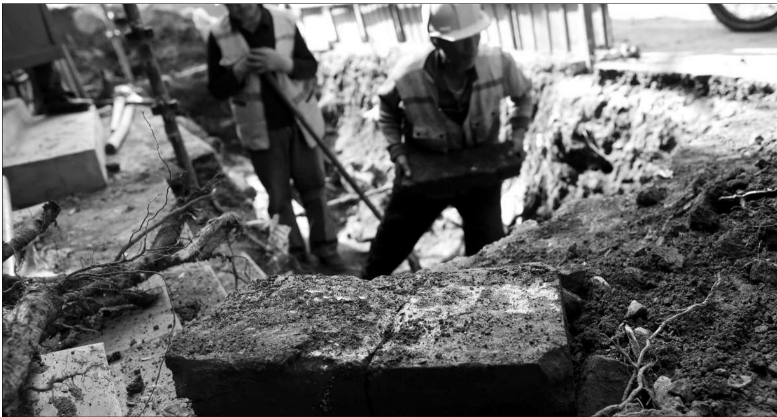
昨日,大乘巷,一位施工人员挖出青砖。西城区文委工作人员表示,初步断定这些砖是老砖,但是否为“老城砖”需进一步鉴定。
