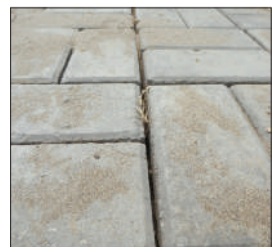
干堤上使用酥砖(左)。地砖不平间隙大(右)。《南京晨报》供图
