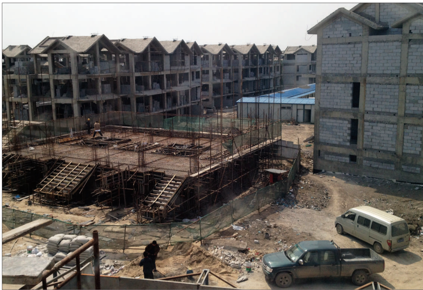
4月14日,记者实地采访发现,星耀五洲项目内部多处都在施工。
