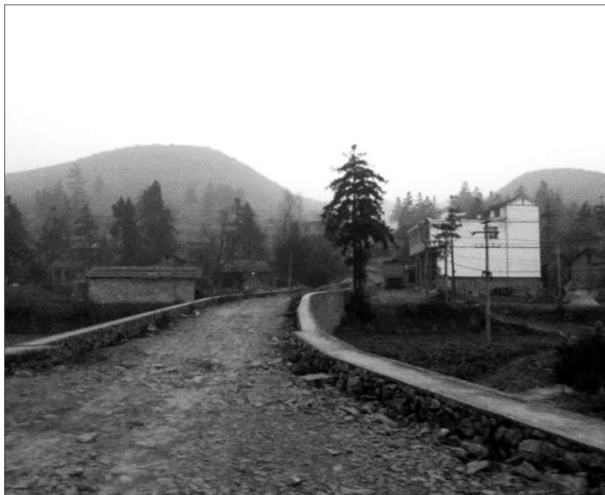
3月14日,施工单位收不到贵州中卫工程款,黔西县头堰村通往“卫星基站”的道路停工了。
