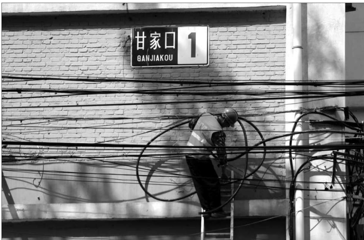
昨日,甘家口1号楼,一名工作人员在拆除电线杆后重新接电源供电。
