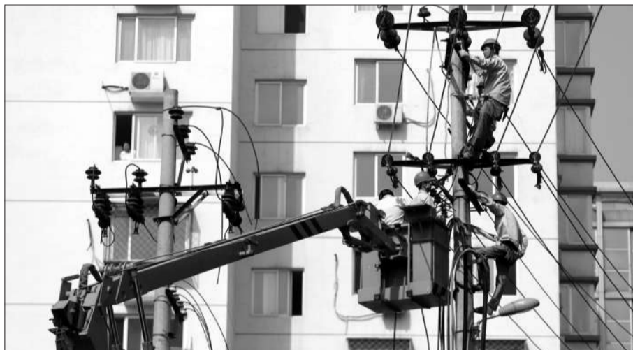
昨日,甘家口4号楼,几名工作人员在拆除旧的电线杆。
