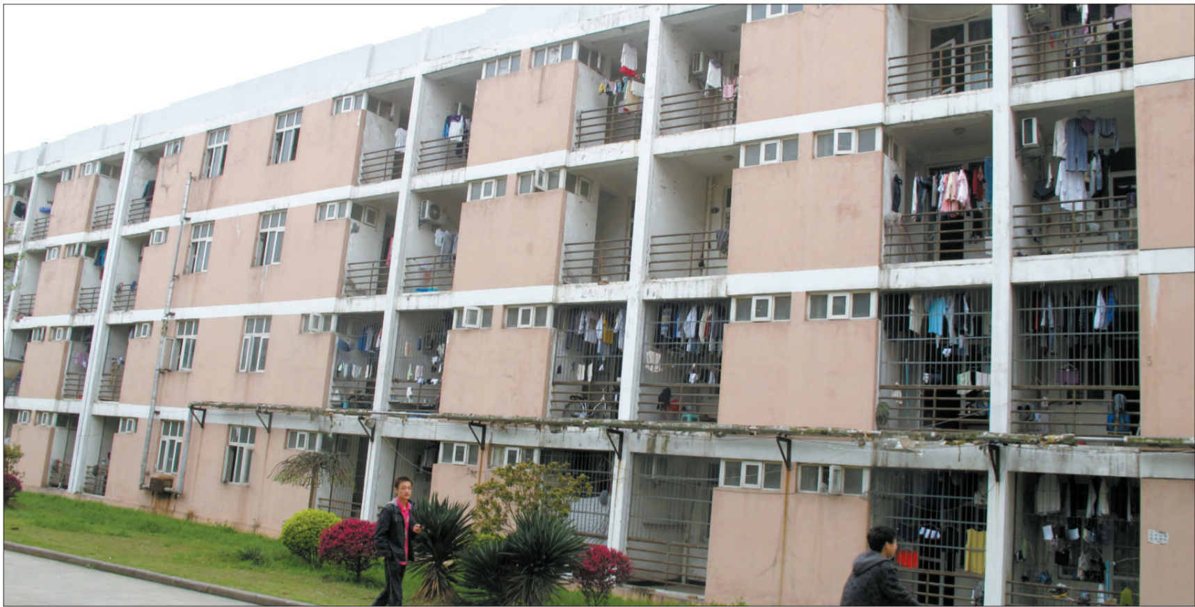
4月12日,武汉东湖高新区茅店学生公寓,据介绍该楼已建成十多年。目前被“贴牌”为去年开建的保障房项目。 A12-A13版摄影/新京报记者 杨万国
