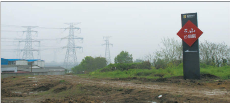
4月15日,花山镇,这里是湖北省保障房示范基地。目前工程进行中,多数还处于大坑状态。
