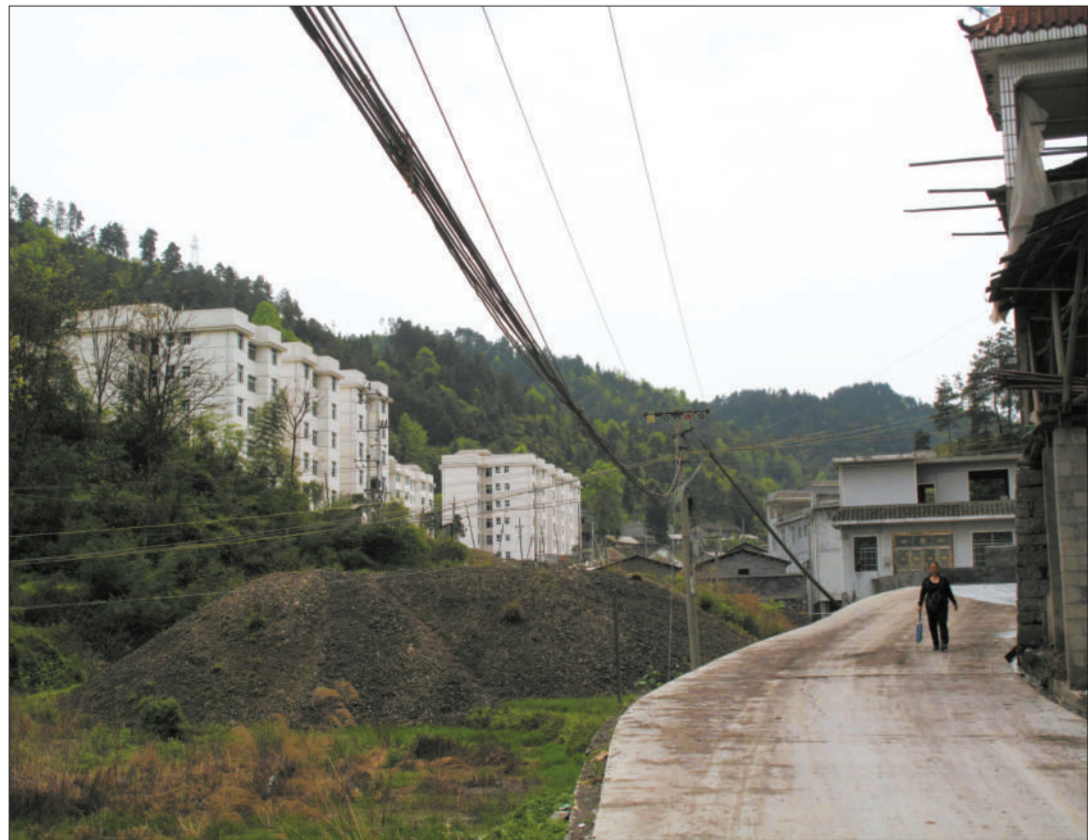
▼4月17日,凤凰县即将竣工的田菜垅廉租房工程,地处偏远。不过建筑成本却因“开山”而更高。
