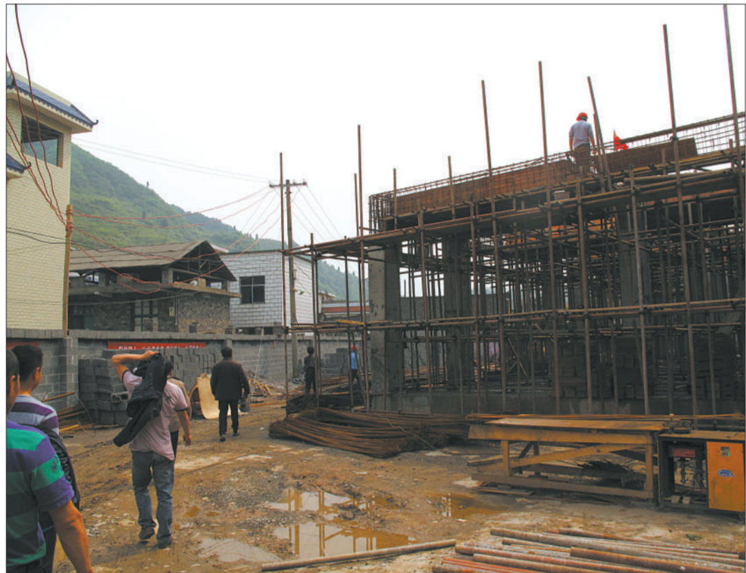
▲4月20日,刚刚开建的吉首市河溪镇廉租房工程。建筑商称担心工程最终会亏本。 新京报记者 陈宁一 摄
