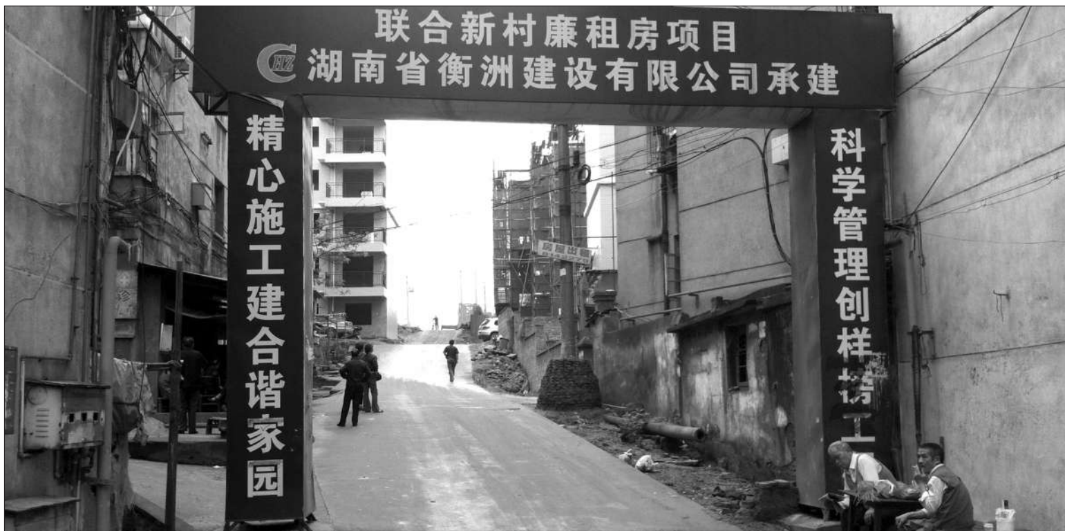
5月4日,湖南省衡阳市。正在建的联合新村廉租房项目,几乎位于中心城区,地段较好。
