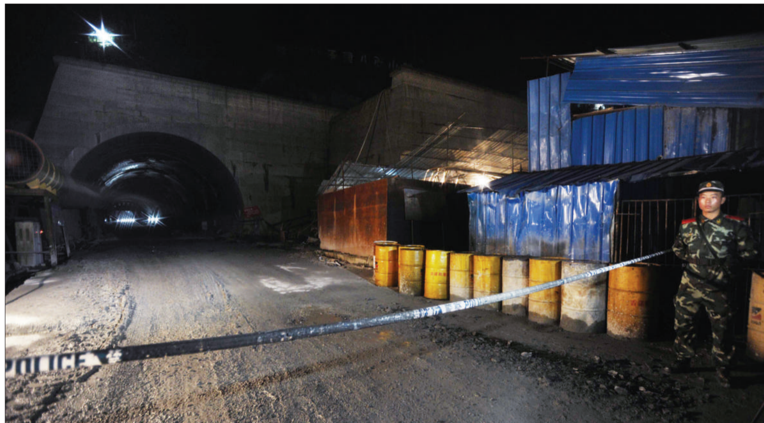
20日凌晨,一名救援人员在发生事故的隧道口警戒。19日,湖南炎陵县境内在建炎汝高速一隧道发生炸药爆炸事故,造成20人死亡。 新华社记者 李琼 摄
