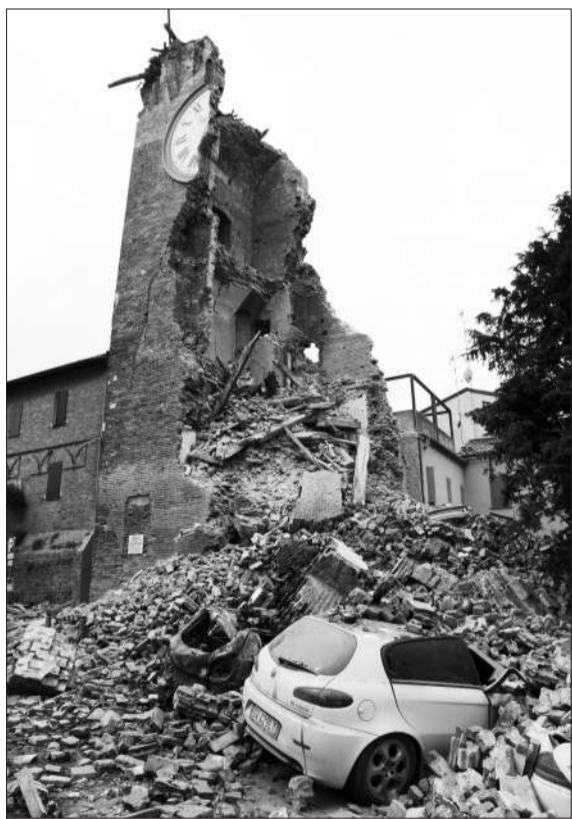
20日,一座古钟塔被震塌只剩一半。
