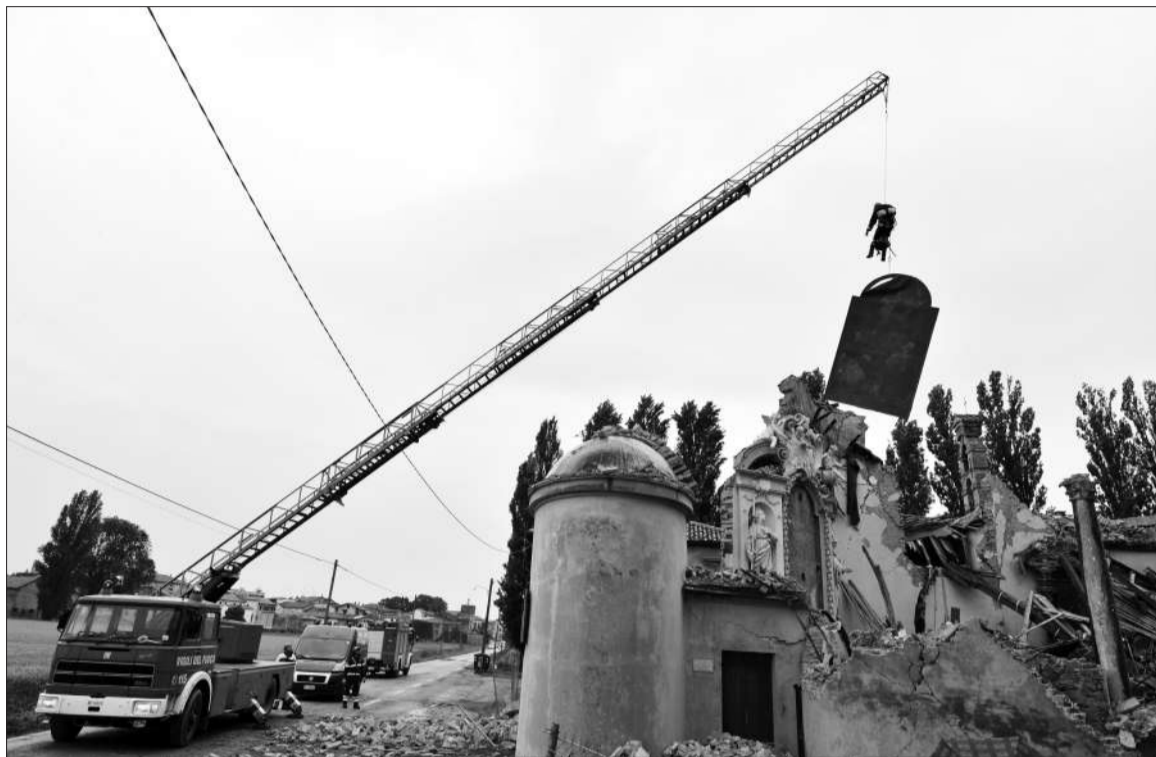
20日,消防人员将一幅画从一座被震塌的教堂吊出。
