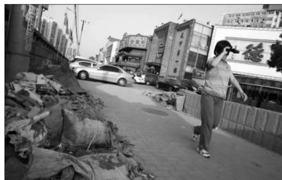
近日,方庄环岛东南角,一些建筑垃圾留在路面上。方庄餐饮街近期将整治。 新京报记者 王嘉宁 摄
