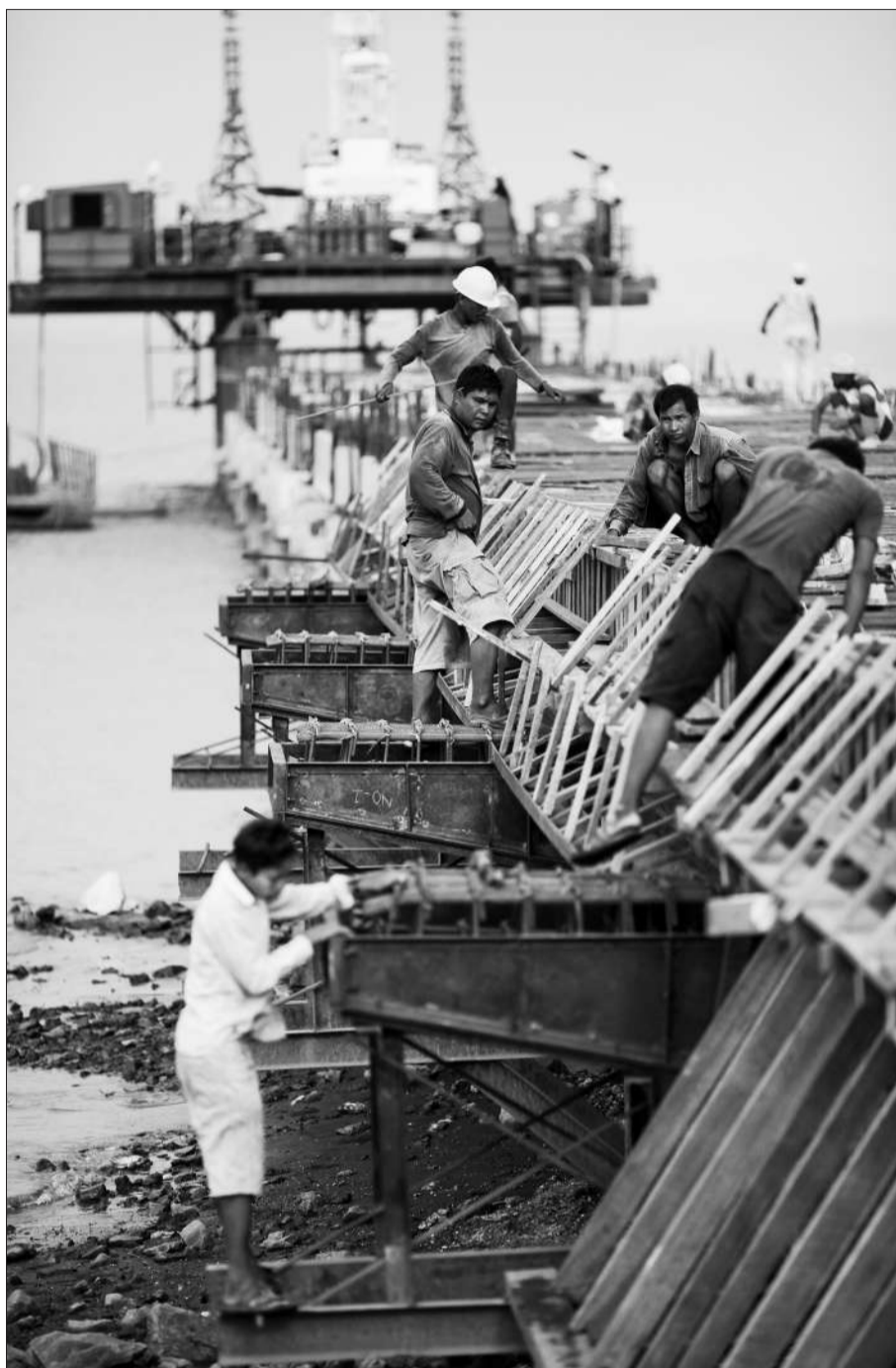
19 日，缅甸实兑，印度爱萨集团工人正在修建港口，这是印度投资缅甸的基础设施建设之一。
