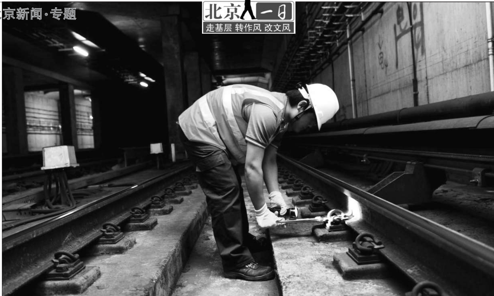
5月27日凌晨,地铁大兴线黄村西大街站隧道,一名地铁巡道员在检查轨道。
