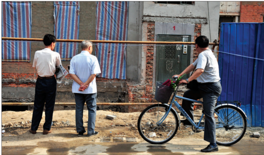
▶5月22日，朝阳区农光里17号楼，老旧小区改造工地现场，路过的人们驻足向工地张望。
