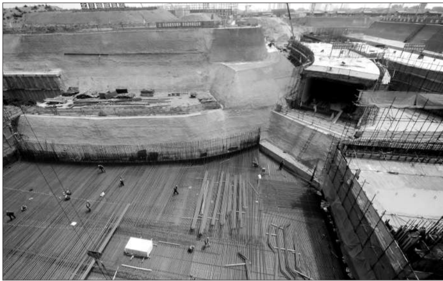
昨日,在新华东路附近的北环环隧施工现场,隧道口已初现雏形。
