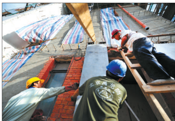
6月14日,农光里社区17号楼改造现场,起重机吊起外墙加固预制板。农光里17号楼于本周开始安装楼体外层加固预制板,目前外观上已有变化。
