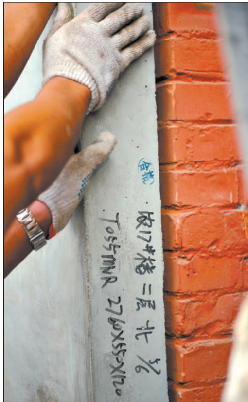
14日,改造现场的工人们正在固定预制板(上图)。预制板统一制作,每一块都有固定位置(下图)。
