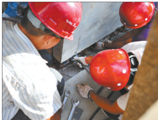
14日,17号楼改造现场,工人们正在拧紧预制板之间的螺丝。
