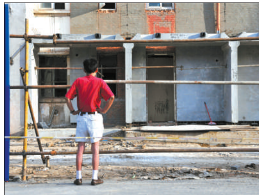
14日,17号楼改造现场,过路人正在观看老旧小区改造后的效果。
