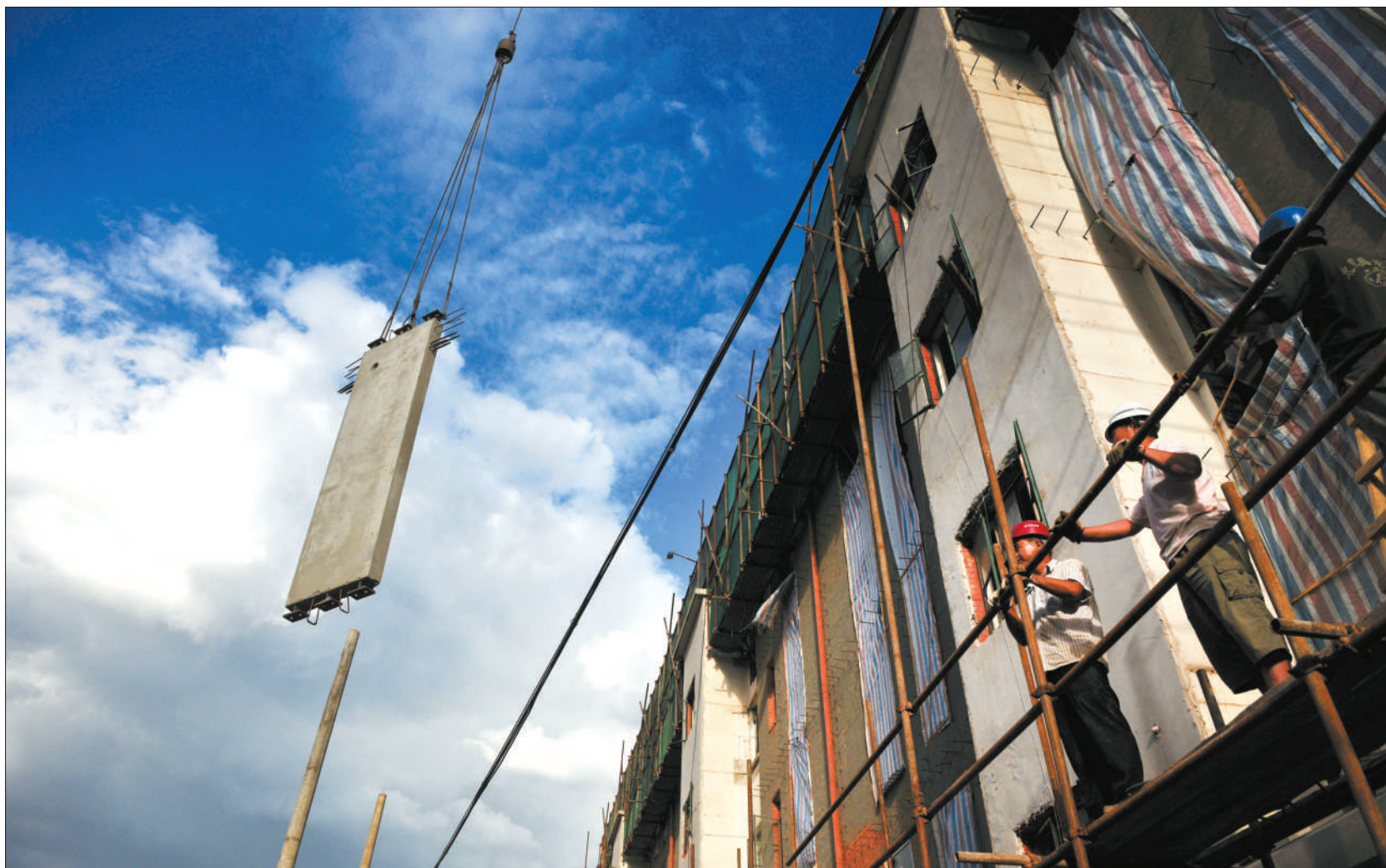
6月14日,农光里社区17号楼改造现场,起重机吊起外墙加固预制板。农光里17号楼于本周开始安装楼体外层加固预制板,目前外观上已有变化。
