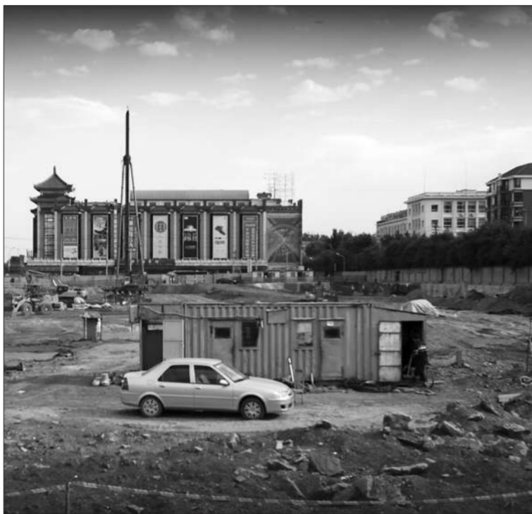
6月11日,天桥艺术中心工地,年内将完成土方施工。 新京报记者 王嘉宁 摄
