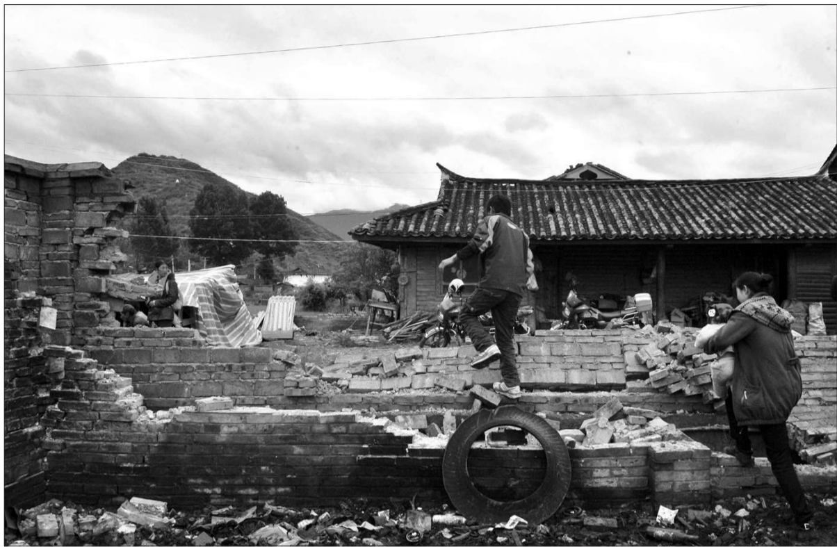
昨日,云南省永宁乡上开基村村民翻越坍塌的院墙。
