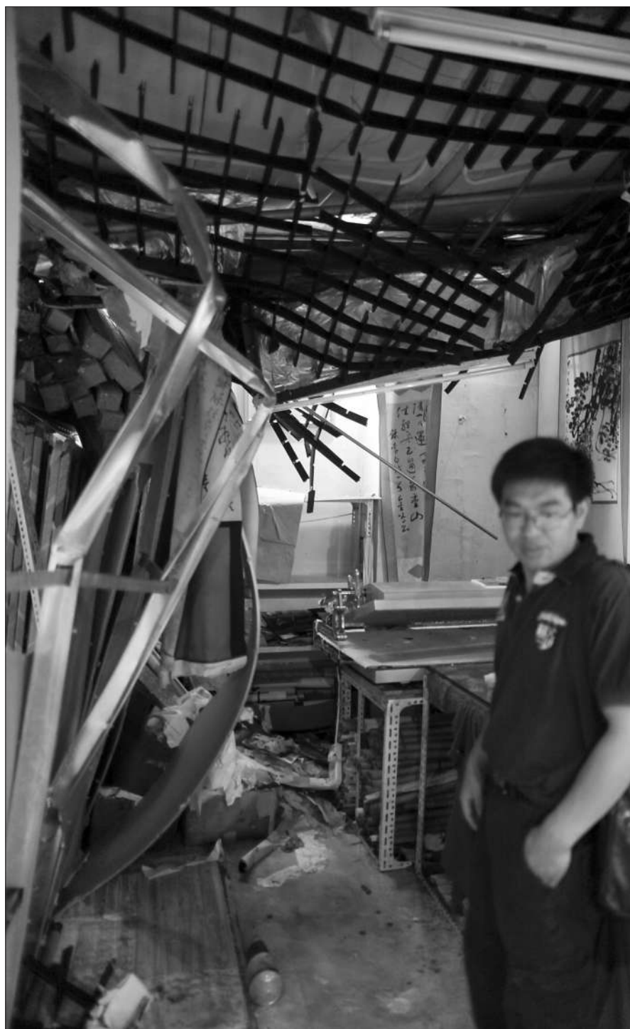
一商铺屋顶被雨水冲塌。前日,海淀一收藏市场因漏雨,数十家商铺遭水泡。
