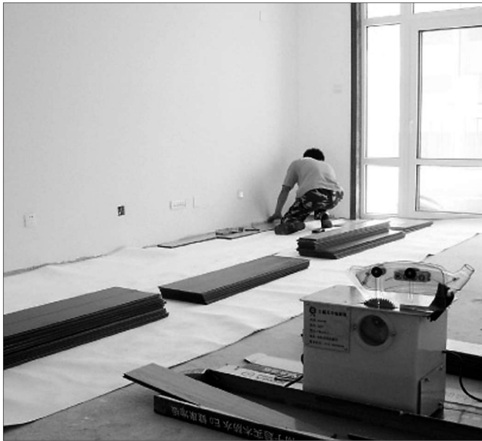
地板铺装可以请地板厂家派专业工人进行专业安装。
