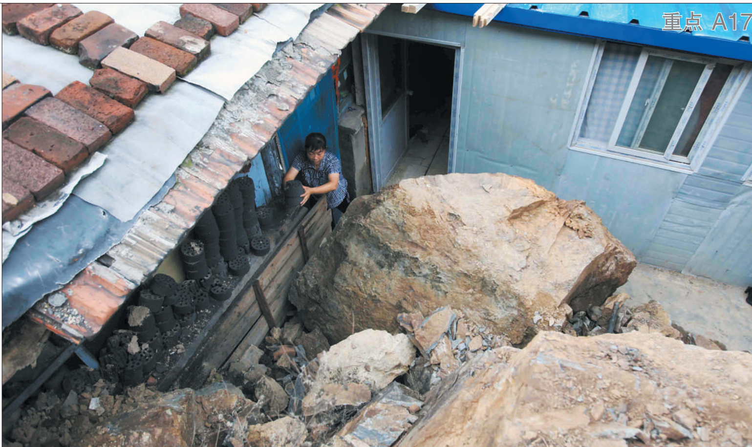
7月26日,门头沟区大台街道张秀群家院内,由于大雨造成山体滑坡,2米多高的巨石滚落院内。家人被及时撤离,没有造成伤亡。 新京报记者 王贵彬 摄
