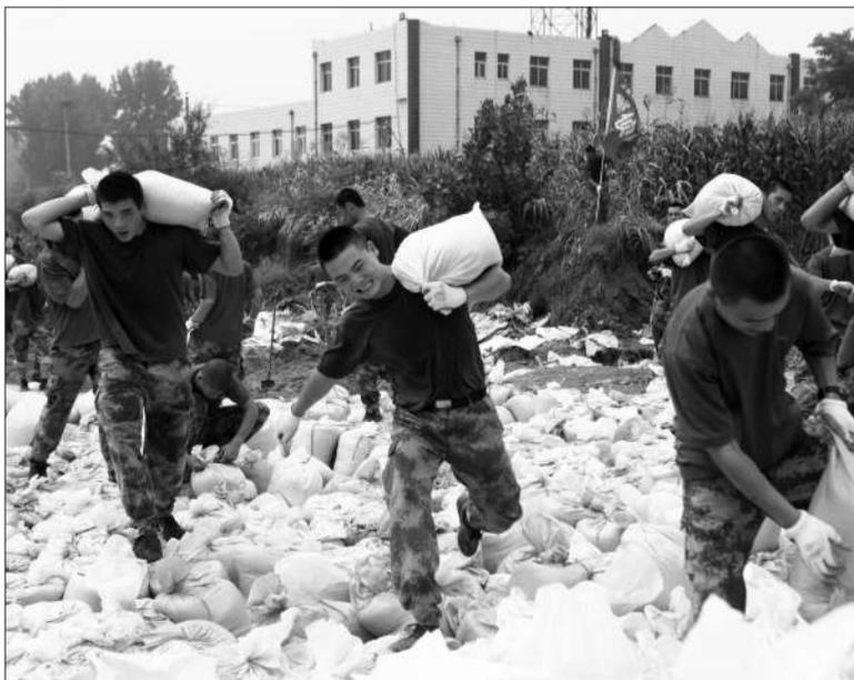
房山区东沙河的堤坝21日被冲毁,此后筑起两道防线。由于27日晚的强降雨,水位线距离坝顶太近,卫戍区的官兵用沙袋将堤坝加高了一米。
