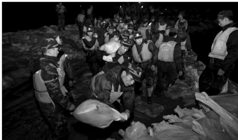
前晚,房山暴雨,东沙河水量出现上涨,武警和解放军战士连夜加固临时堤坝。
