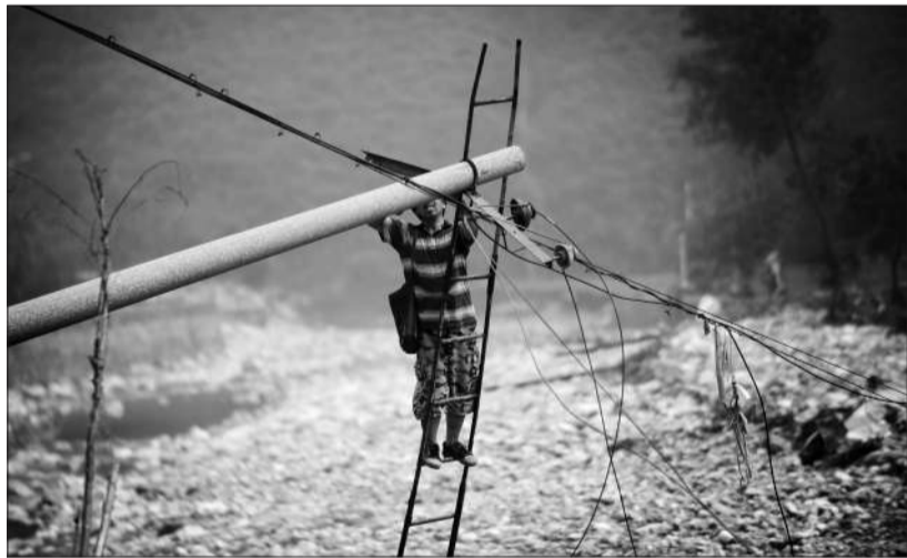
28日,房山区周口店镇夹括河边的一根通讯电线杆在洪水中倒下,工作人员正在抢修通讯线。
